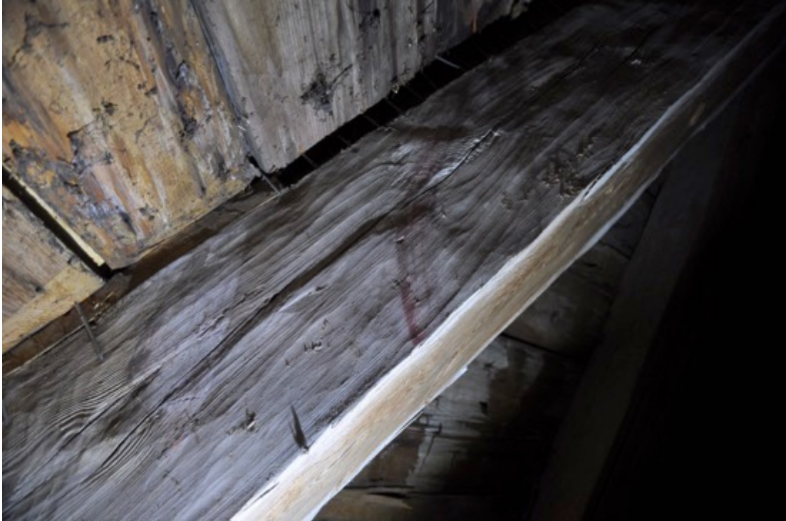
I släpljuset framträder spåren efter skaven, vars rundade stål gett långsgående fåror i veden. Man ser också tydliga rester av måleri.
