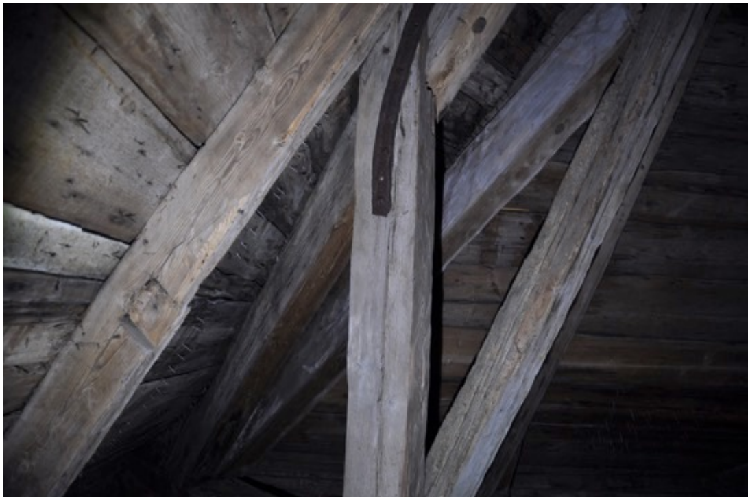
Överst, mitt i bild, en troligen medeltida smidesdetalj. I bakgrunden ett väggtimmer med skavd och bemålad yta.
